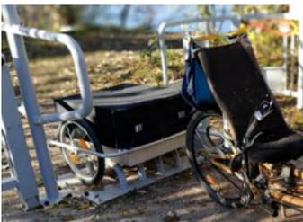
Globalement satisfaits, nous avons demandé de diminuer la hauteur du dispositif au sol pour être compatible avec le passage de la remorque. Nous avons également conseillé d'enterrer les boulons de fixation qui peuvent accrocher et créer une gêne.
