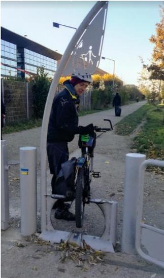
Ce dispositif est très efficace contre les deux roues motorisés, mais génère également des difficultés de passage pour les vélos simples et davantage pour les vélos avec sacoches, les vélos cargos, les tricycles et les vélos avec remorque.
