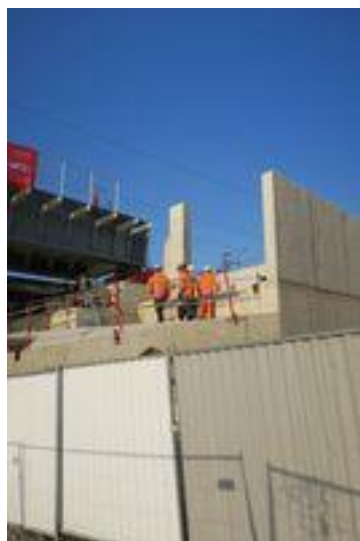
La culée en attente du tablier.
