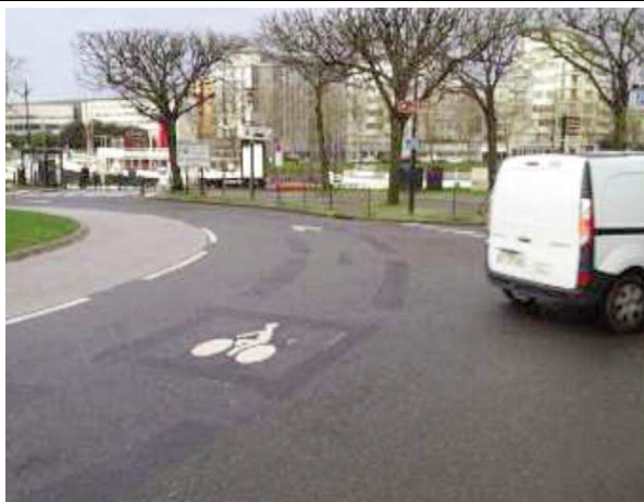
Nantes : marquage au centre de l'anneau d'un giratoire
