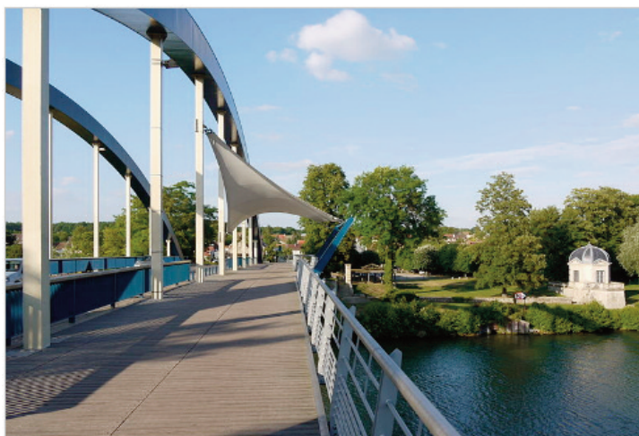
Élargissement pour piétons et vélos du pont de Neuville (depuis 2006)
