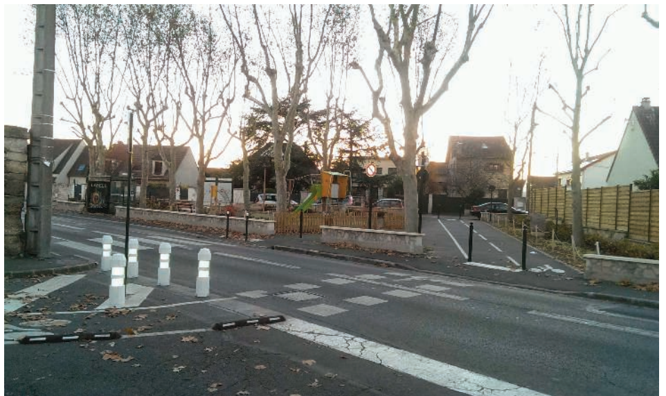
L'aménagement cyclable du petit square dit « du 18 mars 1962 »
