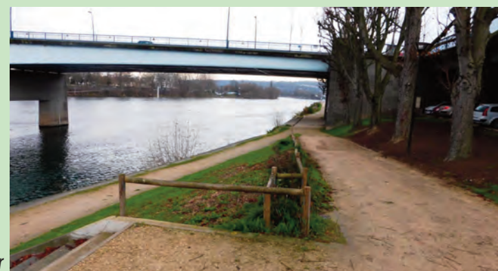
Le chemin de halage sous le pont routier
